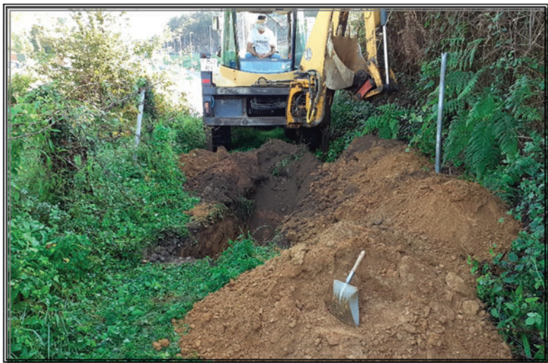
Emplazamiento de la calicata
