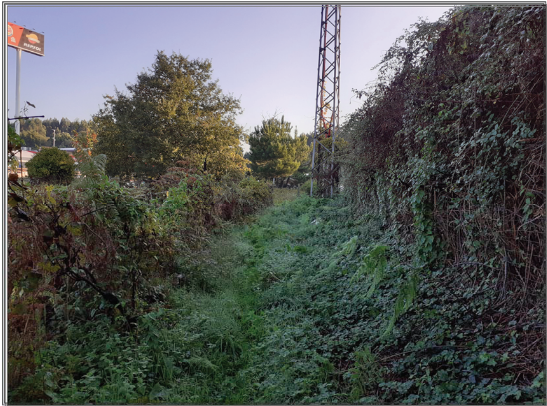
Vista general de la zona de estudio
